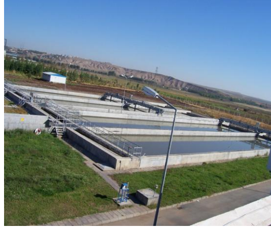
Arıtma Tesisi Kum Tutucular ve Ön Çökeltme Havuzları
