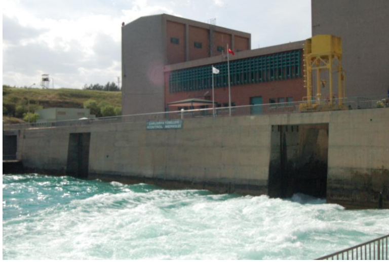
Atatürk Barajı Şanlıurfa Tünelleri Çıkış Ağız
