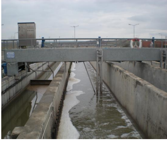
Arıtma Tesisi Kum Tutucular ve Ön Çökeltme Havuzları
