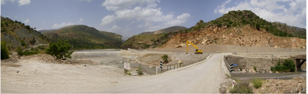
Foto 9. Göksu Nehri Üzerindeki HES İnşaatından Görünüm
